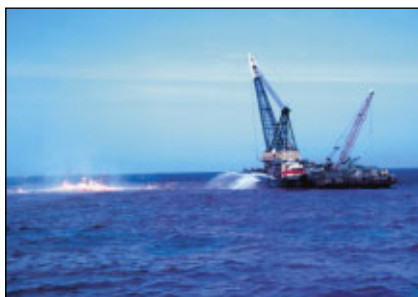
Algunos derrames presentan riesgos de seguridad específicos.
